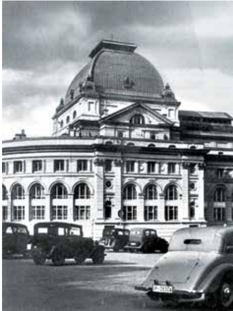
Das Grillo-Theater, das im zweiten Weltkrieg schwer beschädigt wurde.
